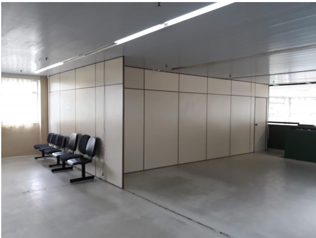
Imagem 1 – Local onde os banheiros serão executados
