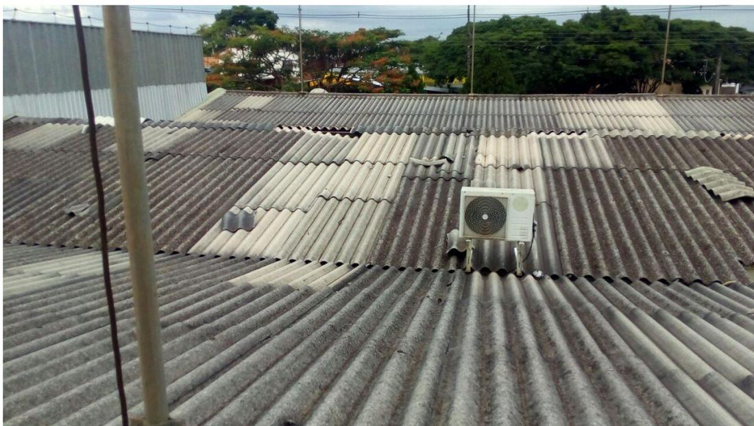
Será instalada subcobertura com manta plástica revestida por película de alumínio, sob as telhas, com intuito de melhorar o desempenho térmico, a eficiência contra as infiltrações das águas de chuvada e evitar que a condensação e acúmulo de umidade ao longo do tempo desencadeia a proliferação de fungos e pragas, aumentando a vida útil da cobertura.
