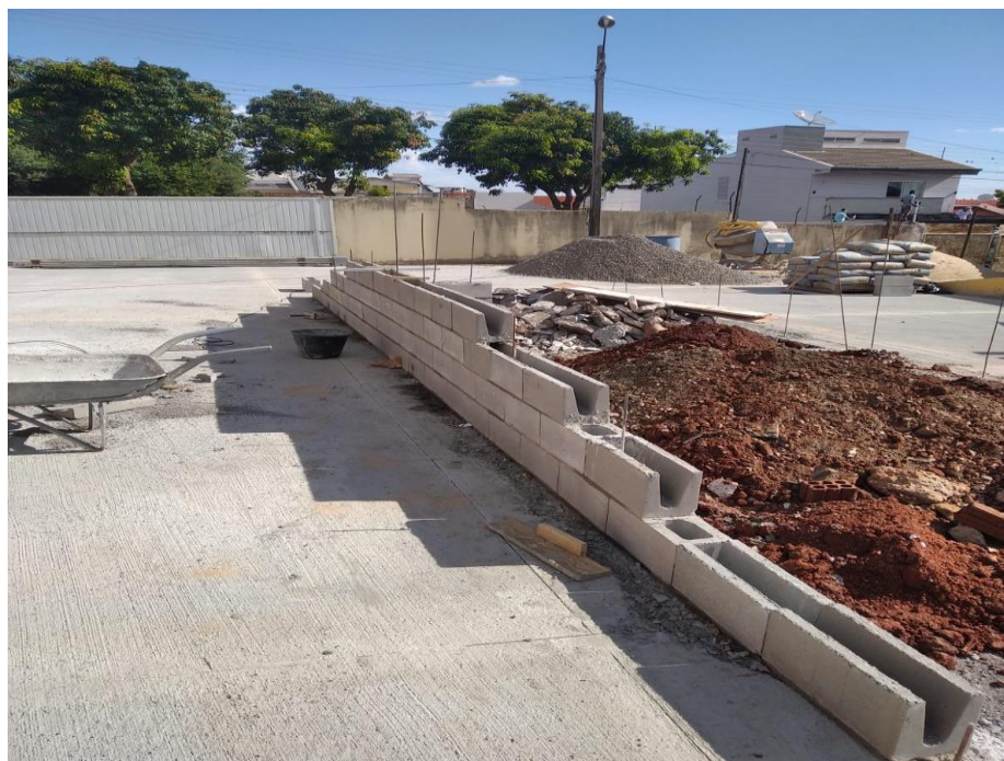
Imagem 18: Execução da estrutura da rampa a ser adotado.
