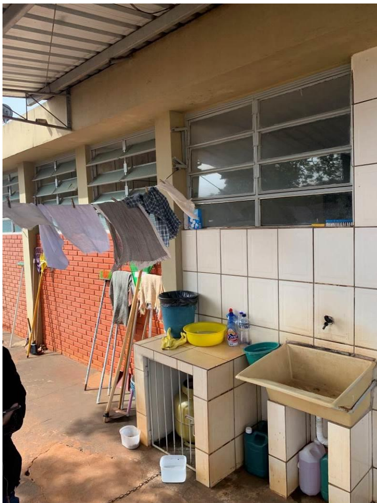
Imagem 9: Casa de gás e tanque existentes
