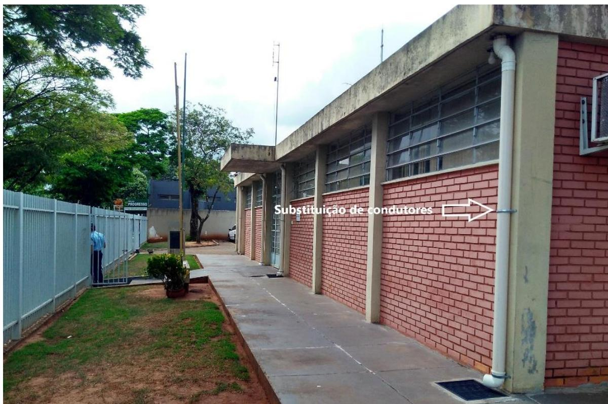
Imagem 14. Substituição de condutores por diâmetros maiores
