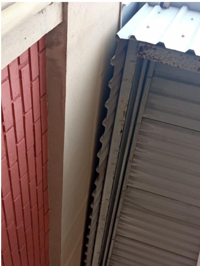
Imagem 22. Local de infiltração na cobertura de vistoria
