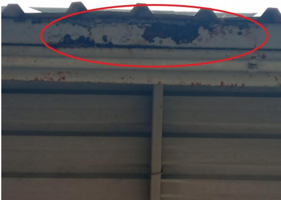
Imagem 20. Pontos de corrosão na cobertura de vistoria
