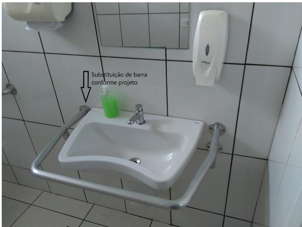
Imagem 29. Substituir barras do lavatório no Banheiro P.C.D.
