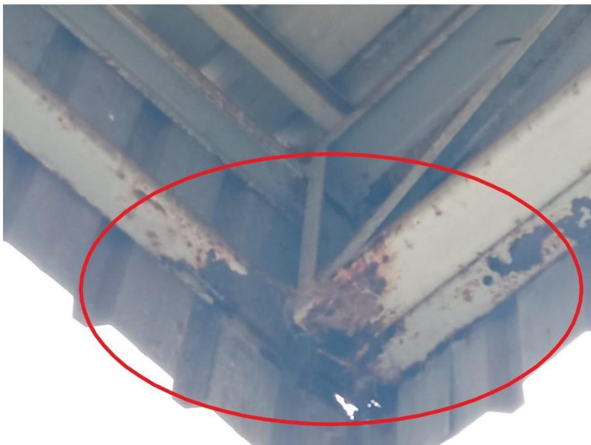
**Imagem 21. Pontos de corrosão na cobertura de vistoria**
