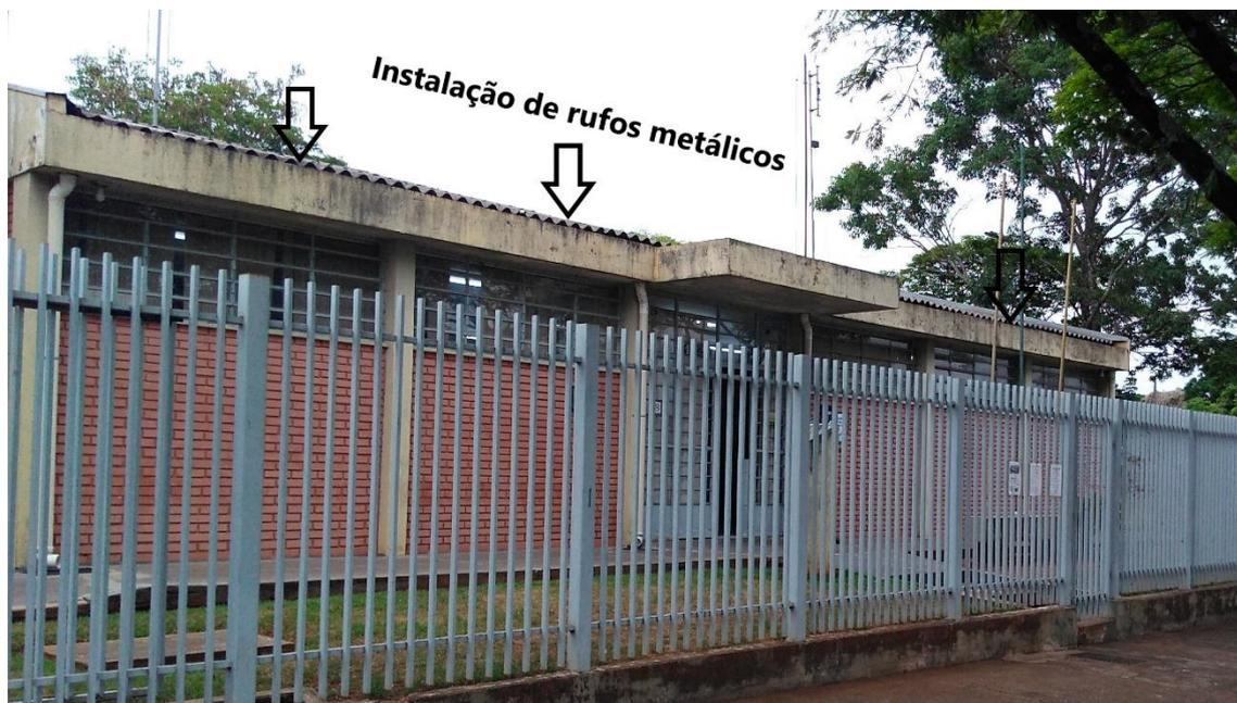
Imagem 15. Instalação de rufos nas platibandas
