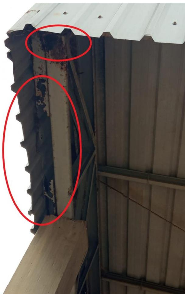
Imagem 19. Pontos de corrosão na cobertura de vistoria
