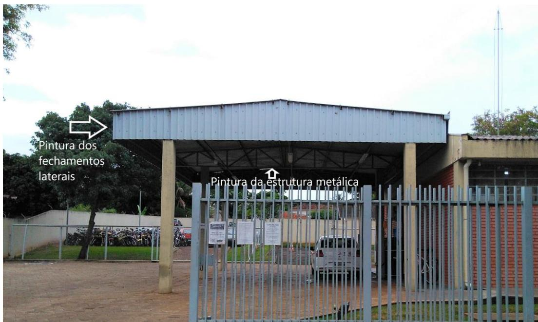
Imagem 47. Cobertura de vistoria – pintura da estrutura metálica e fechamento lateral
