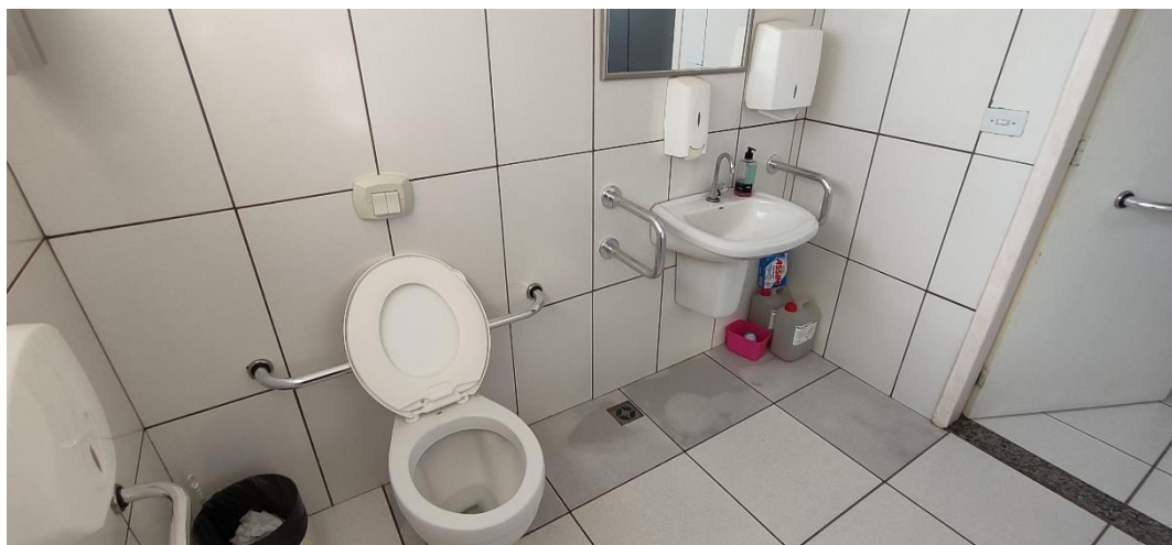
Foto 3: Piso Cerâmico com Infiltração.
