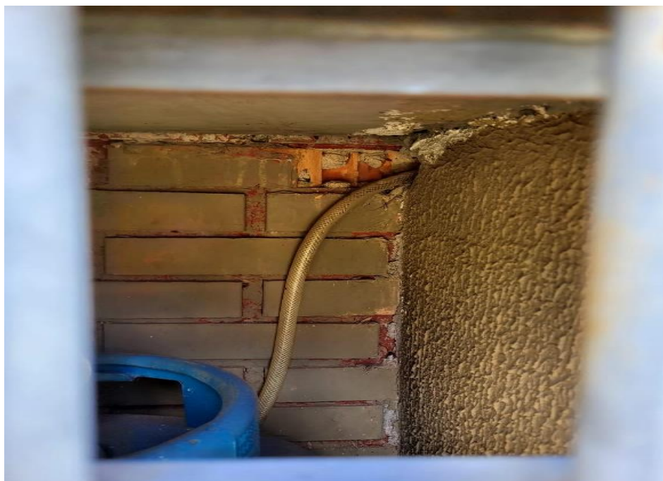
Foto 2: Tubulação de gás existente.
