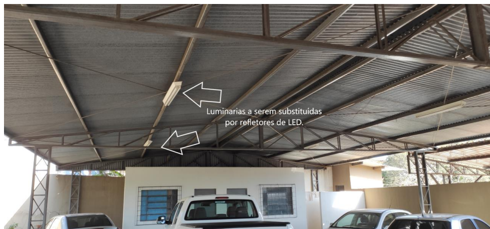
Foto 5: Iluminação da cobertura de vistoria.
