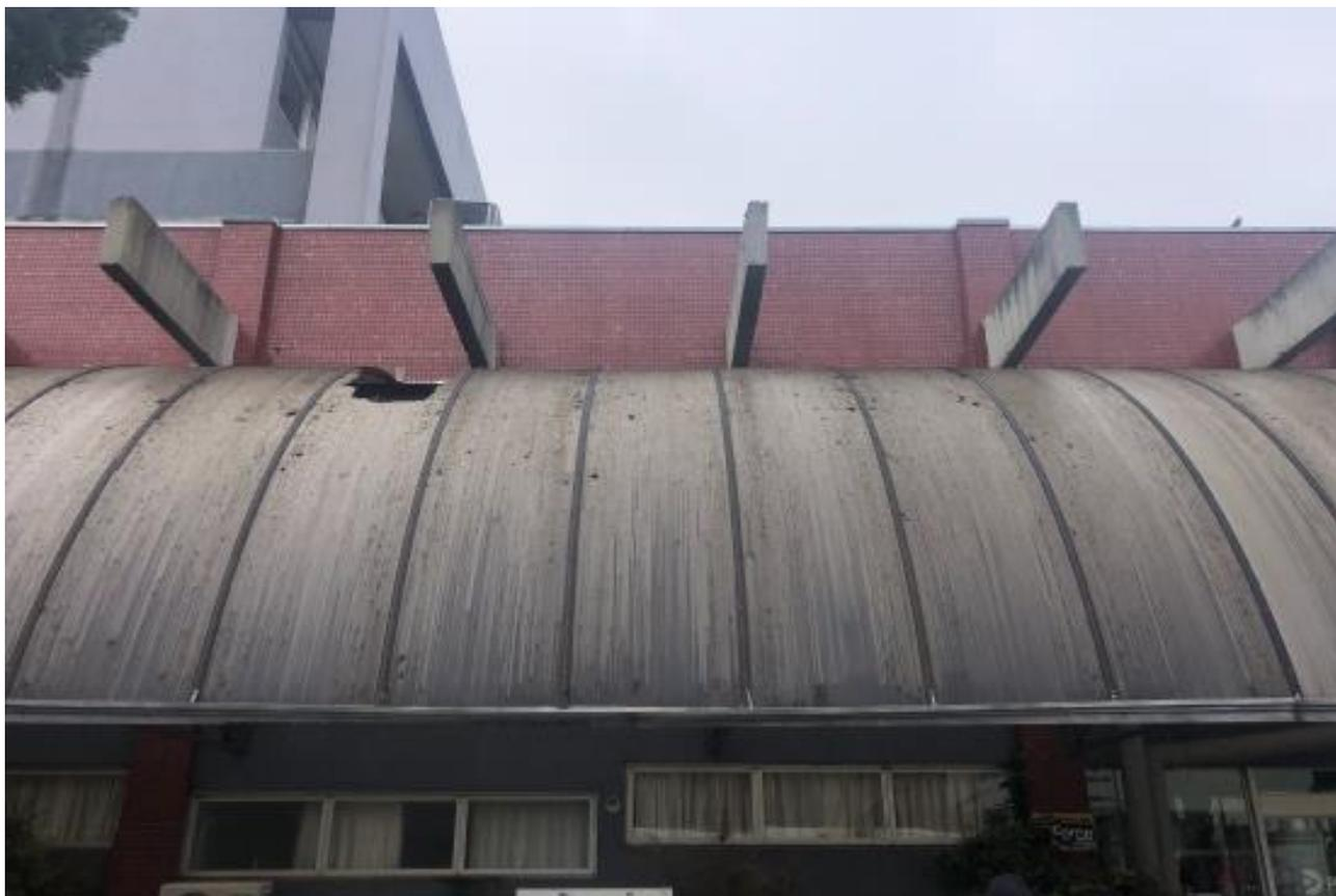
Imagem 1. Cobertura existente no local. Estrutura de aço carbono com placas de policarbonato alveolar
