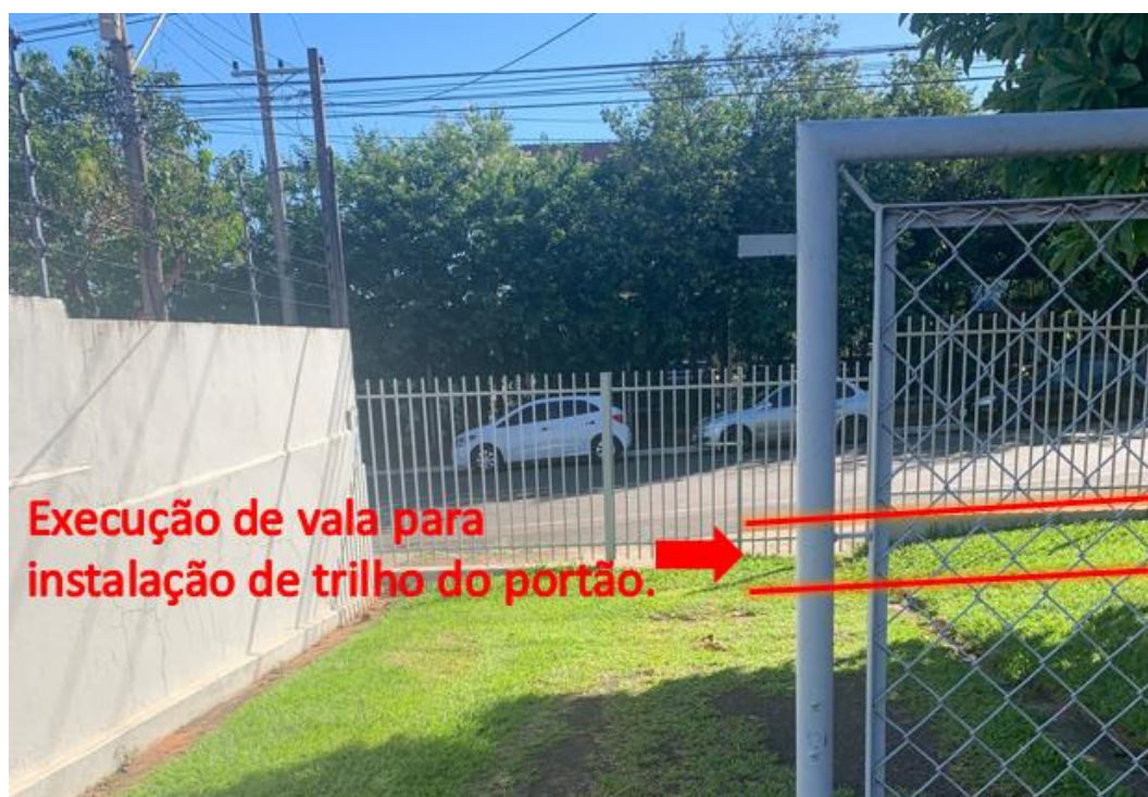
Imagem 9: Execução de vala para trilho.
