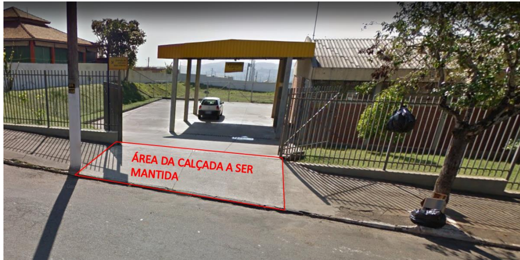
Imagem 10: Acesso a cobertura de vistoria.
