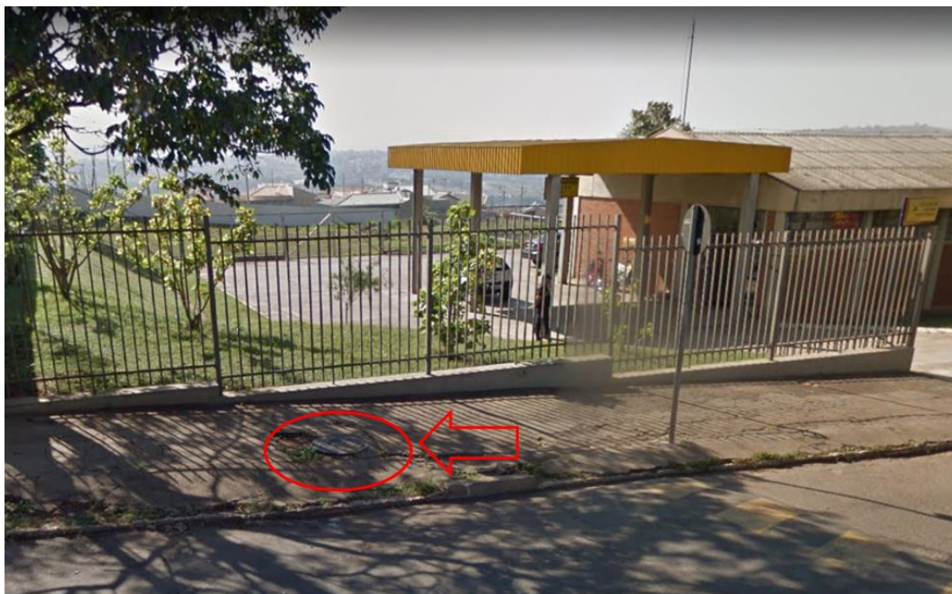
Imagem 11: Ponto de tubulação.
