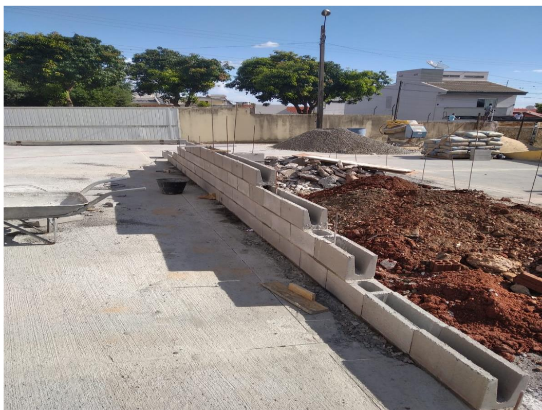
Imagem 4: Execução da estrutura da rampa a ser adotado.
