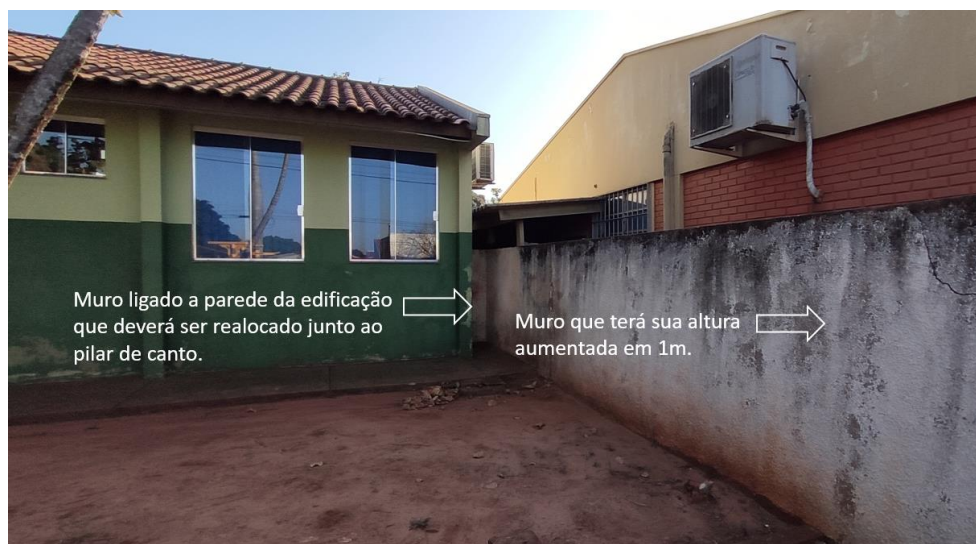
Imagem 6: Muro lateral a cobertura da lavanderia.
