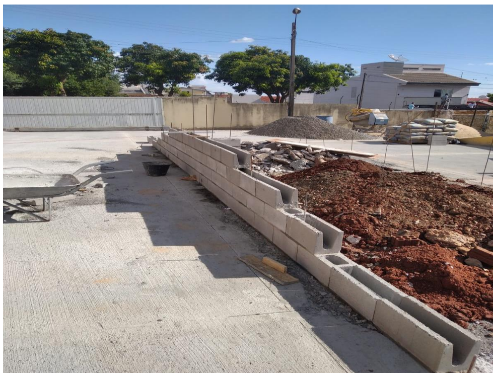
Imagem 3: Execução da estrutura da rampa a ser adotado.
