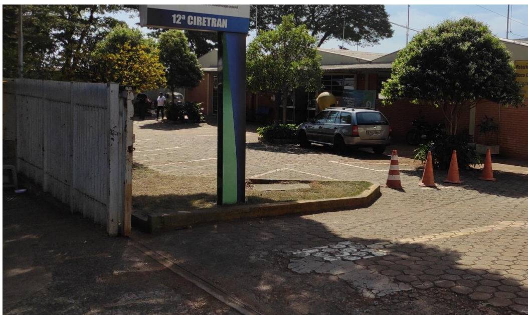
Imagem 28: Pavimento interno a ser reconstituído.
