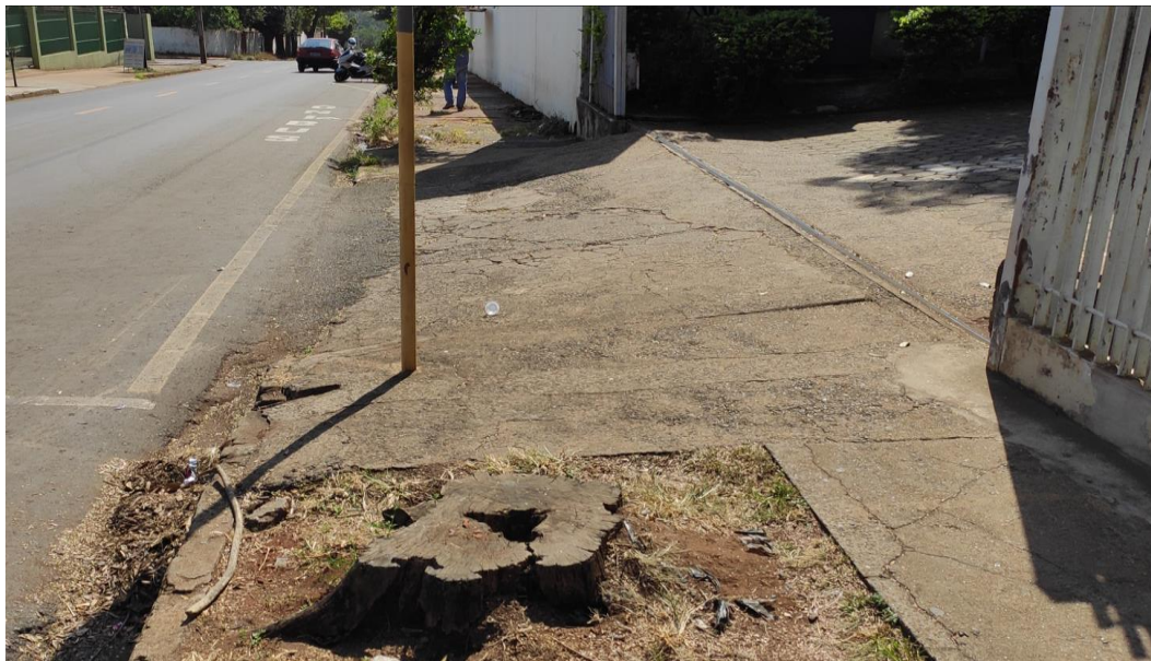
Imagem 27: Calçada externa a ser substituída.
