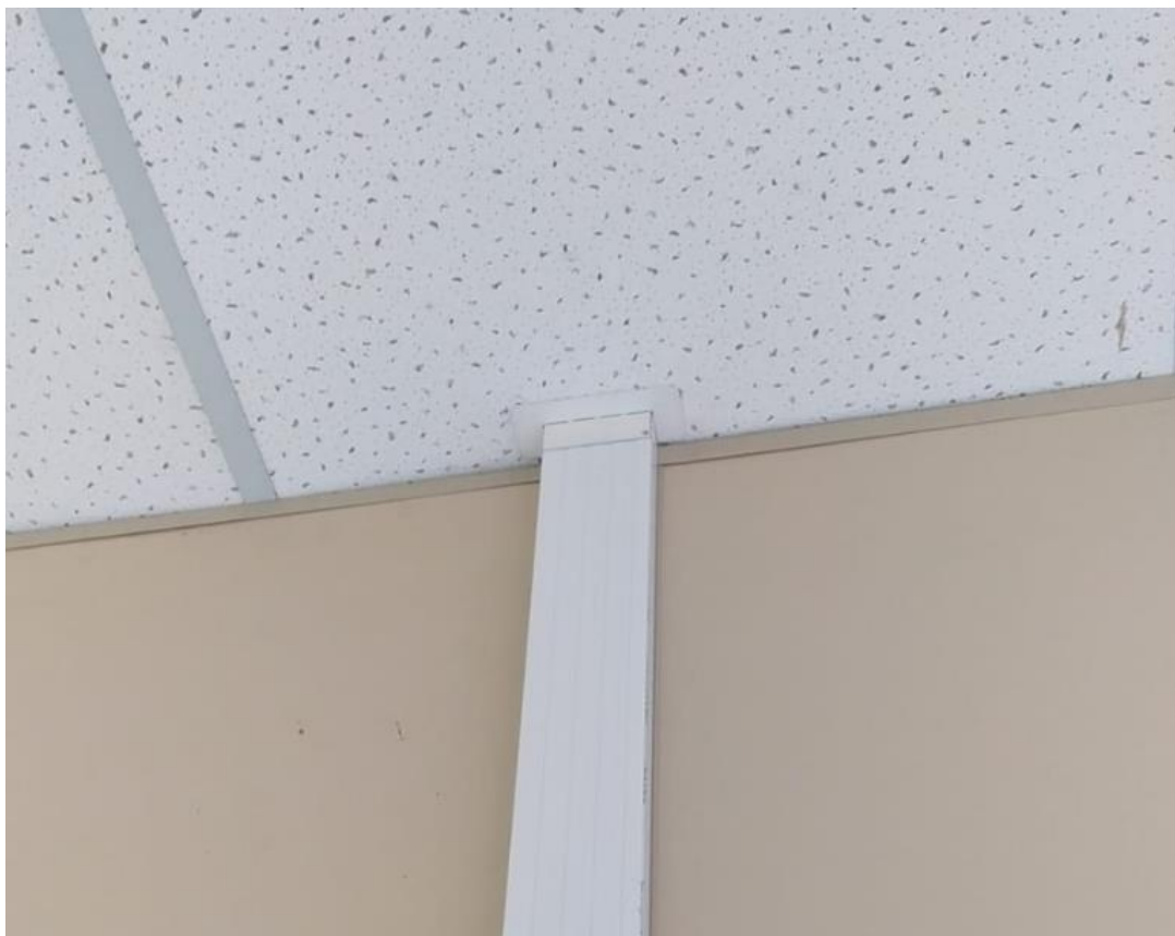
Imagem 18: Arremate de acabamento de teto.
