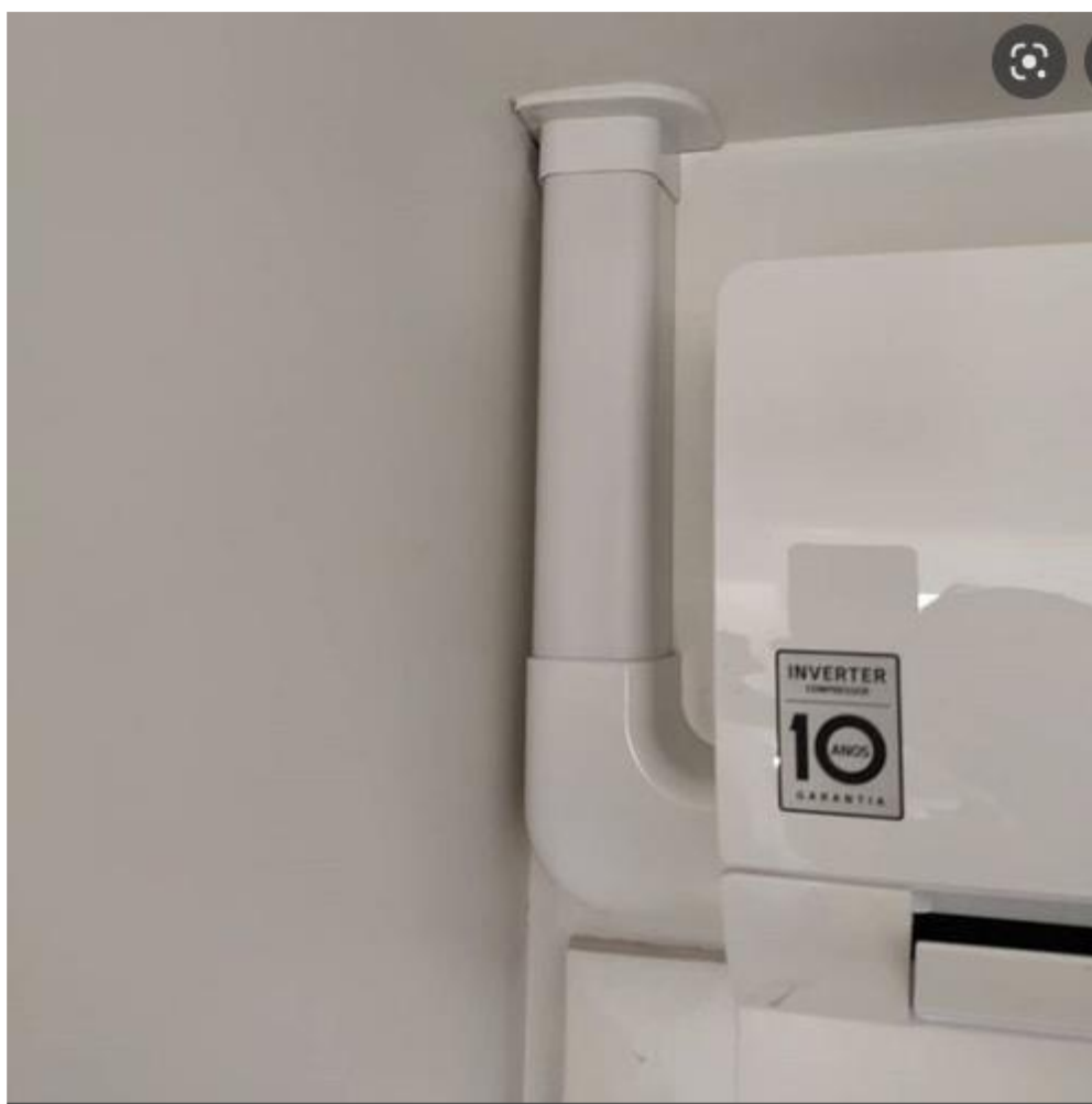
Imagem 11: Canaleta para cobertura de tubulação
