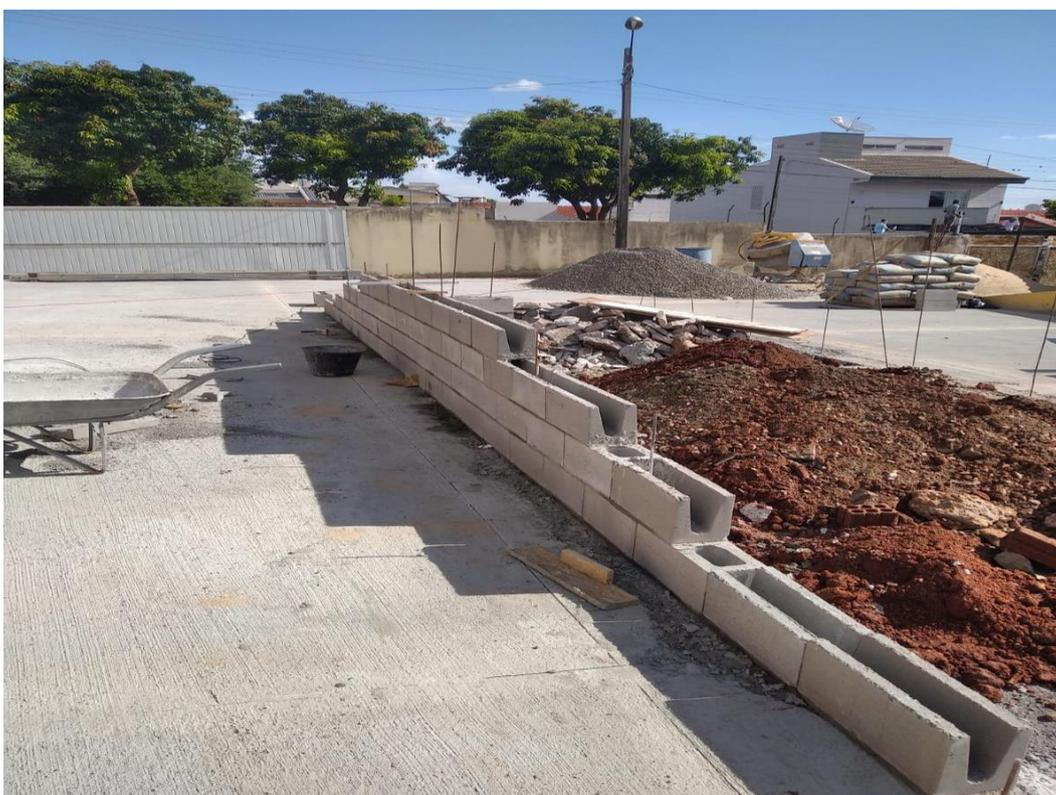
Imagem 26: Execução da estrutura da rampa a ser adotado.
