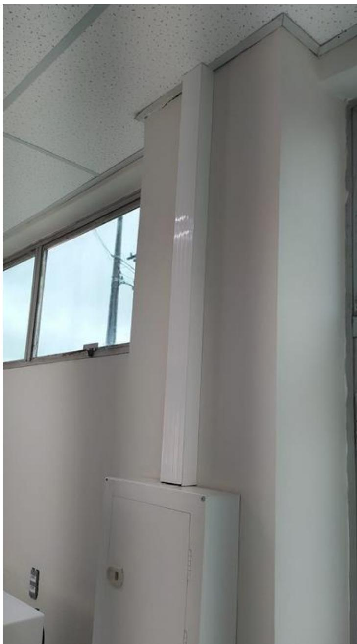
Imagem 44: saída do quadro usando canaleta 45 D em alumínio (Dutotec)
