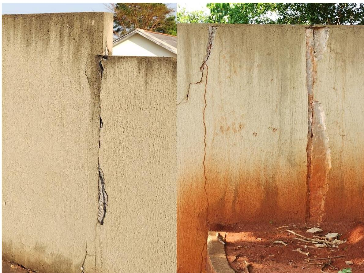
Imagem 12 e 13: Exemplo de local para recuperação com junta de dessolidarização (pista)
