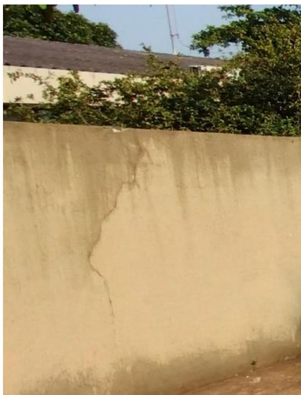
Imagem 11: Exemplo de local com trinca (muro lateral)
