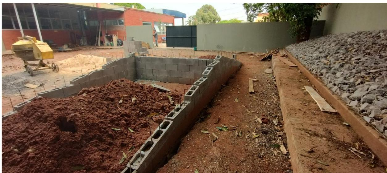
Imagem 22: Execução da estrutura da rampa a ser adotado.
