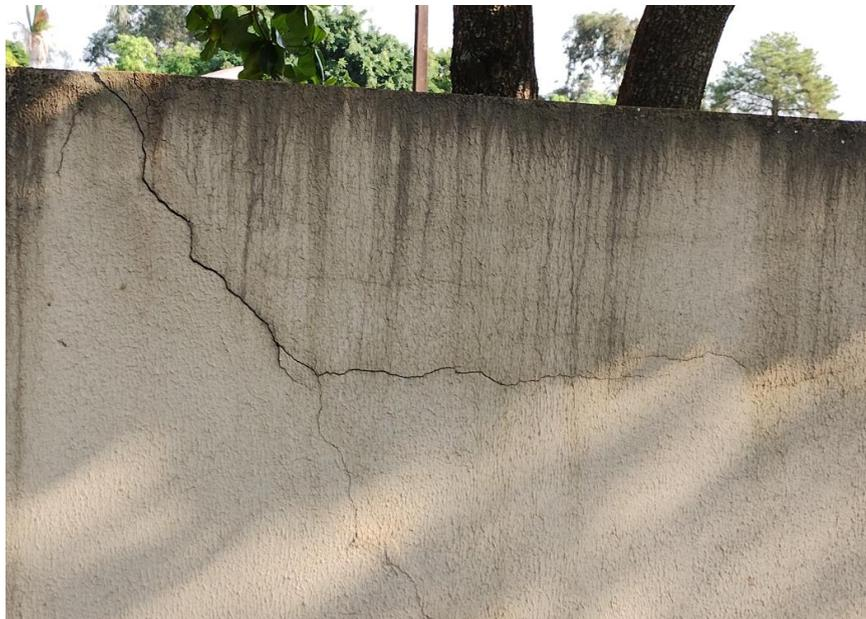
Imagem 10: Exemplo de local com trinca (pista)
