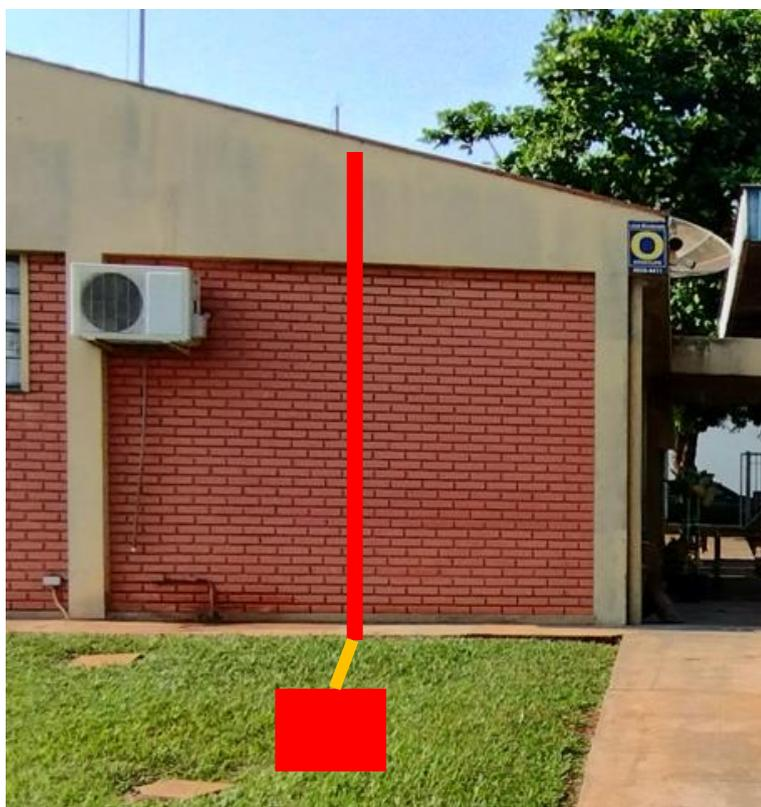
Imagem 43: nova posição do aterramento do para-raio.
