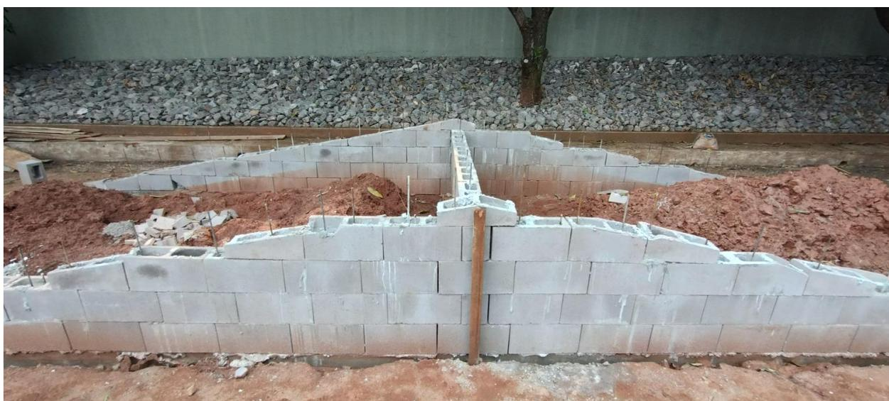
Imagem 21: Execução da estrutura da rampa a ser adotado.
