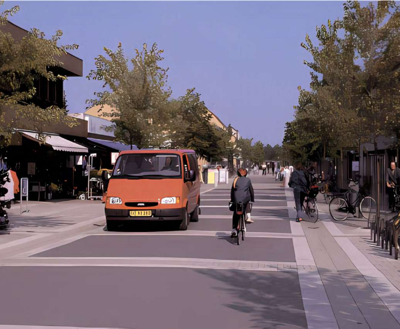
Figura 40 - Elementos verticais no bordo da via e no pavimento induzem os condutores a dirigir em velocidades mais baixas.
