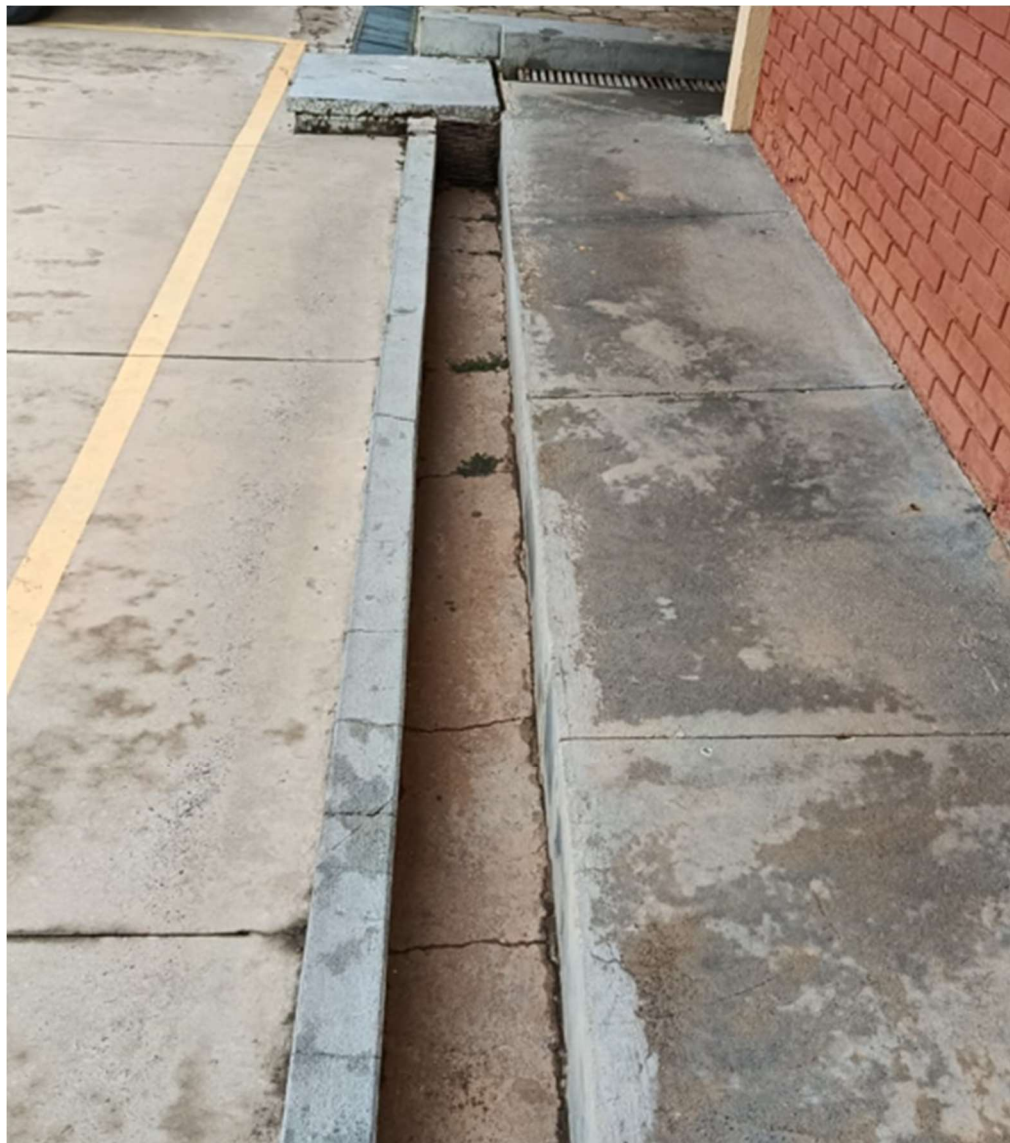
Imagem 6: Instalação de grelha em canaleta existente.
