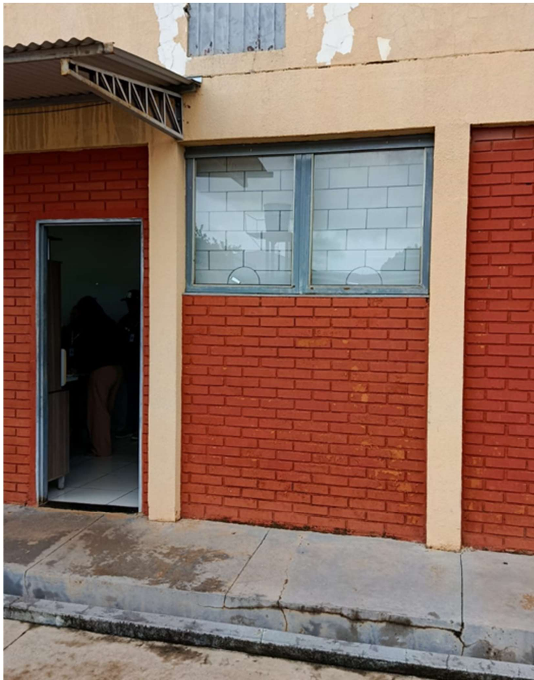
Imagem 7: Local para execução de porta de correr.
