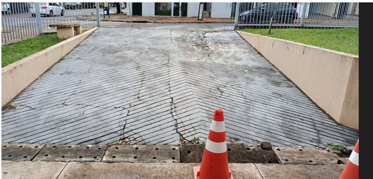
Imagem 1: Rampa de acesso principal.
