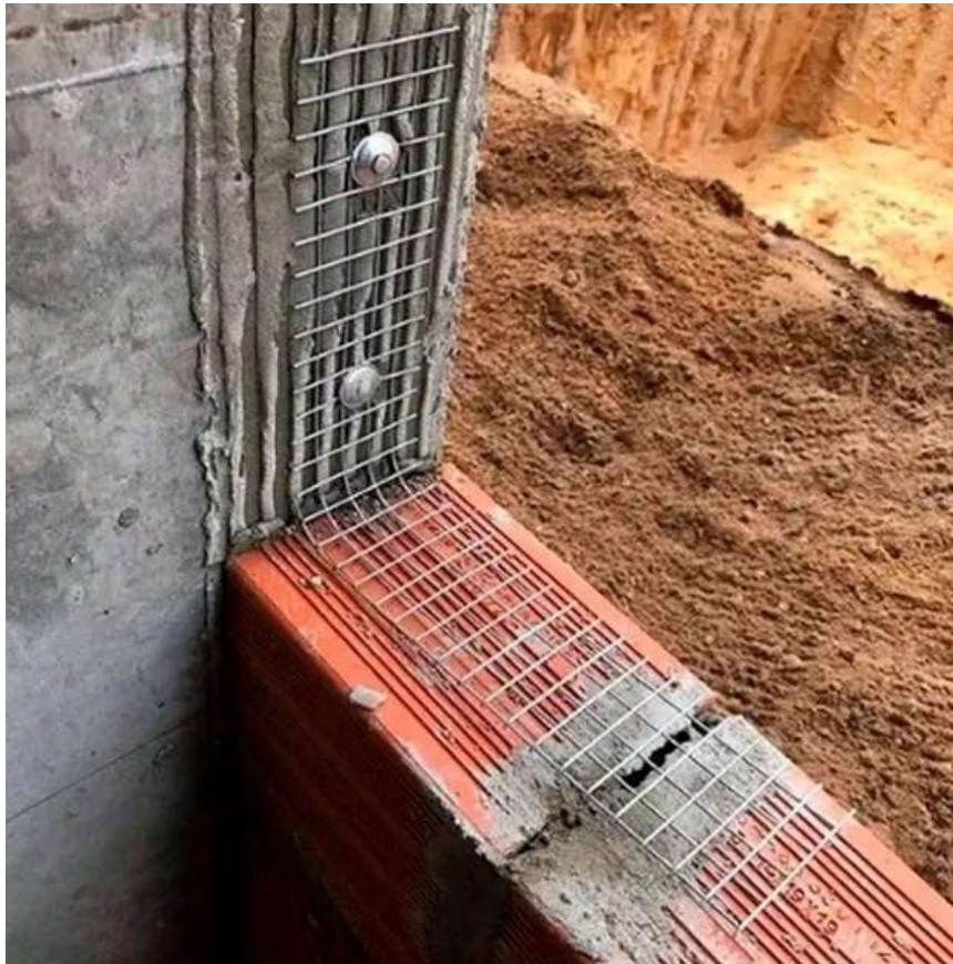
Imagem 4: Exemplo 1 de colocação de tela de fixação de alvenaria.
