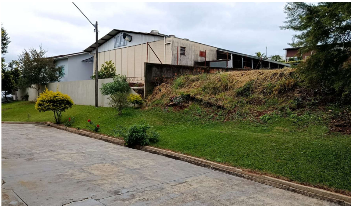
Imagem 1: Local de execução do novo muro.
