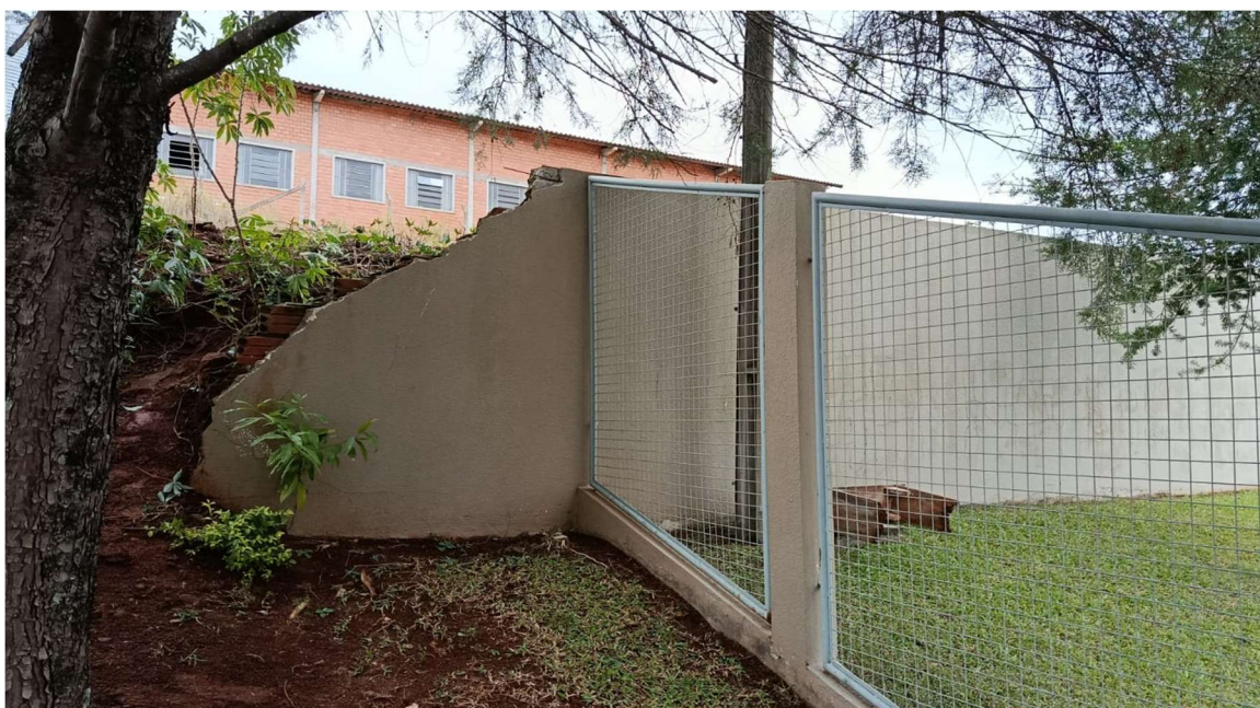
Imagem 2: Parte do muro a ser demolido.
