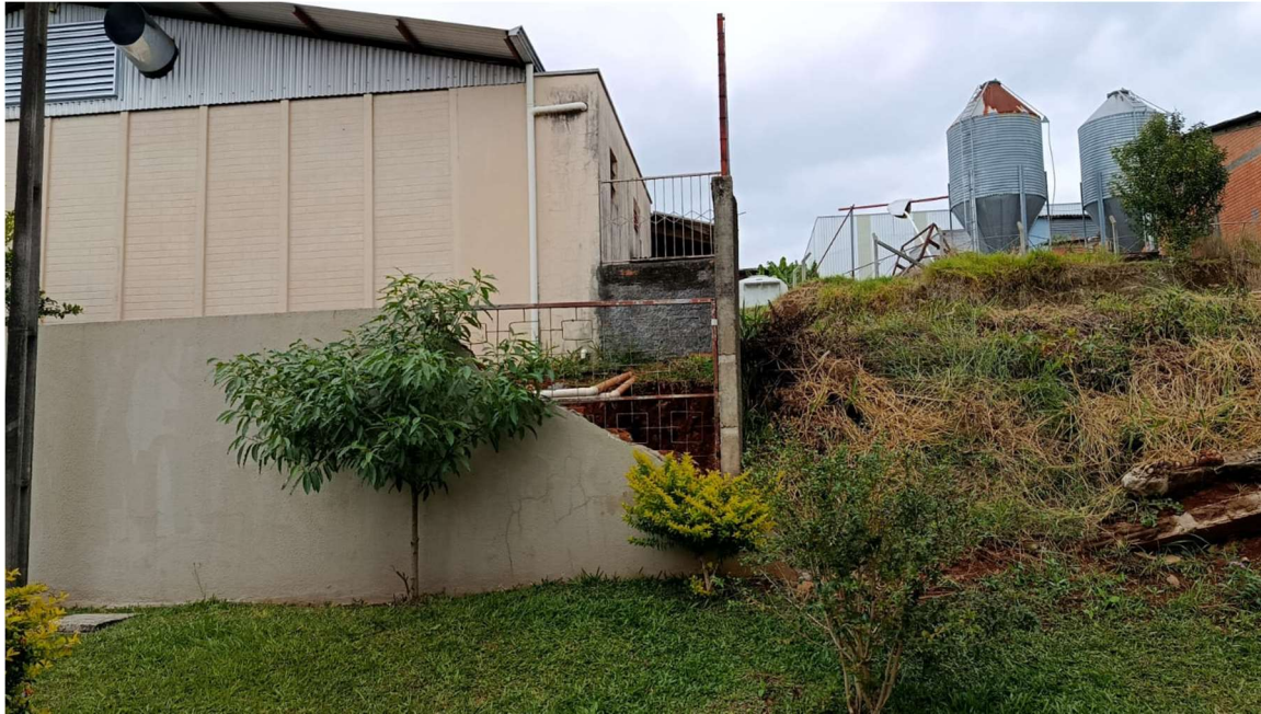
Imagem 3: Parte do muro a ser demolido.
