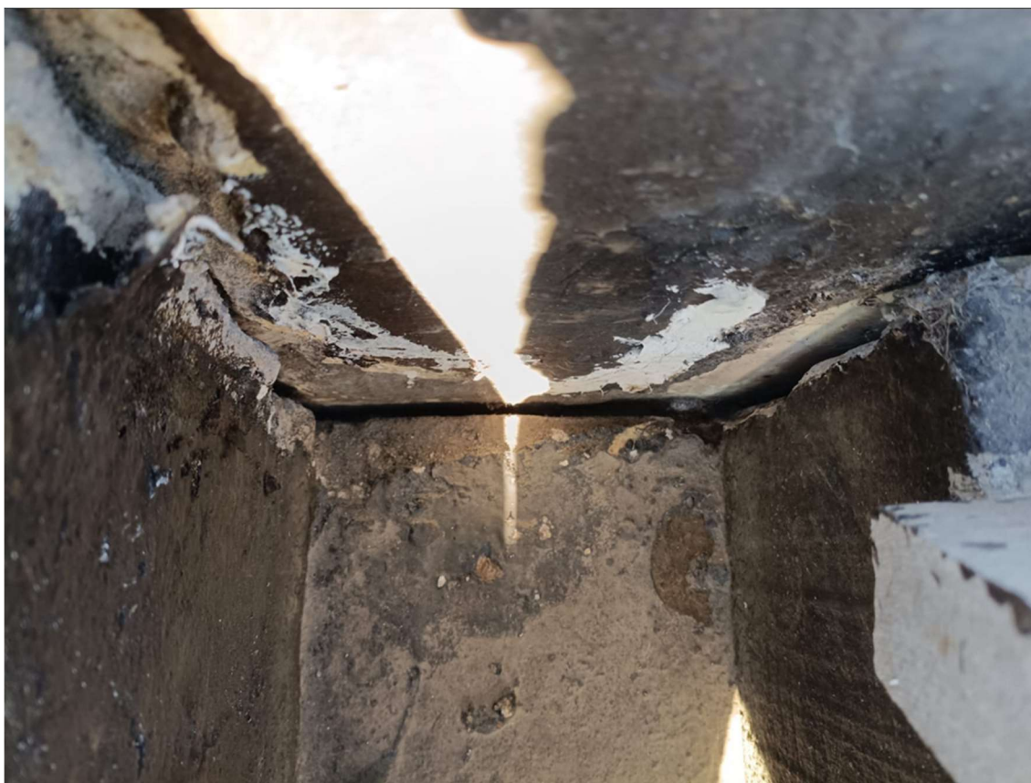
Imagem 4: Junta de dilatação localizada na calha.
