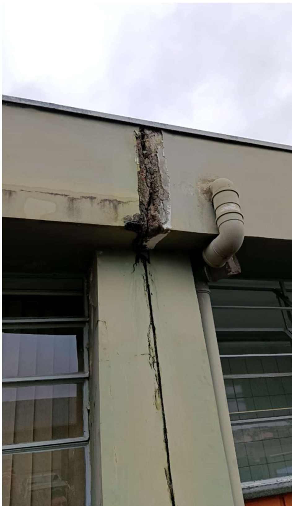
Imagem 8: Execução de junta de desolidarização na área externa.
