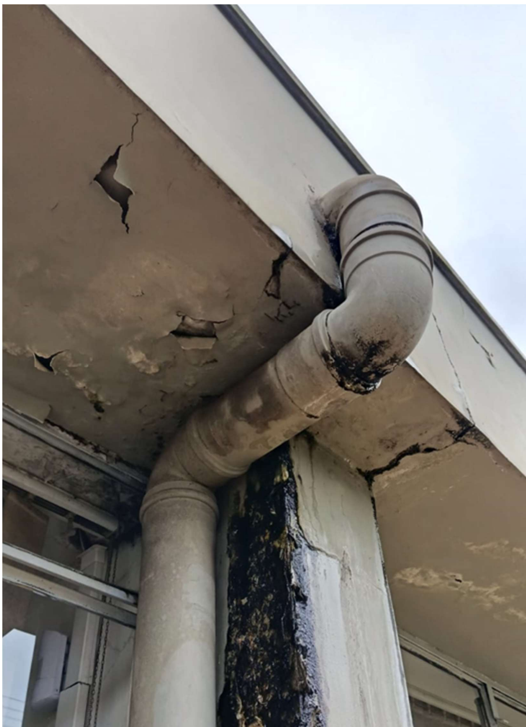
Imagem 5: Tubos a serem removidos e furos vedados.
