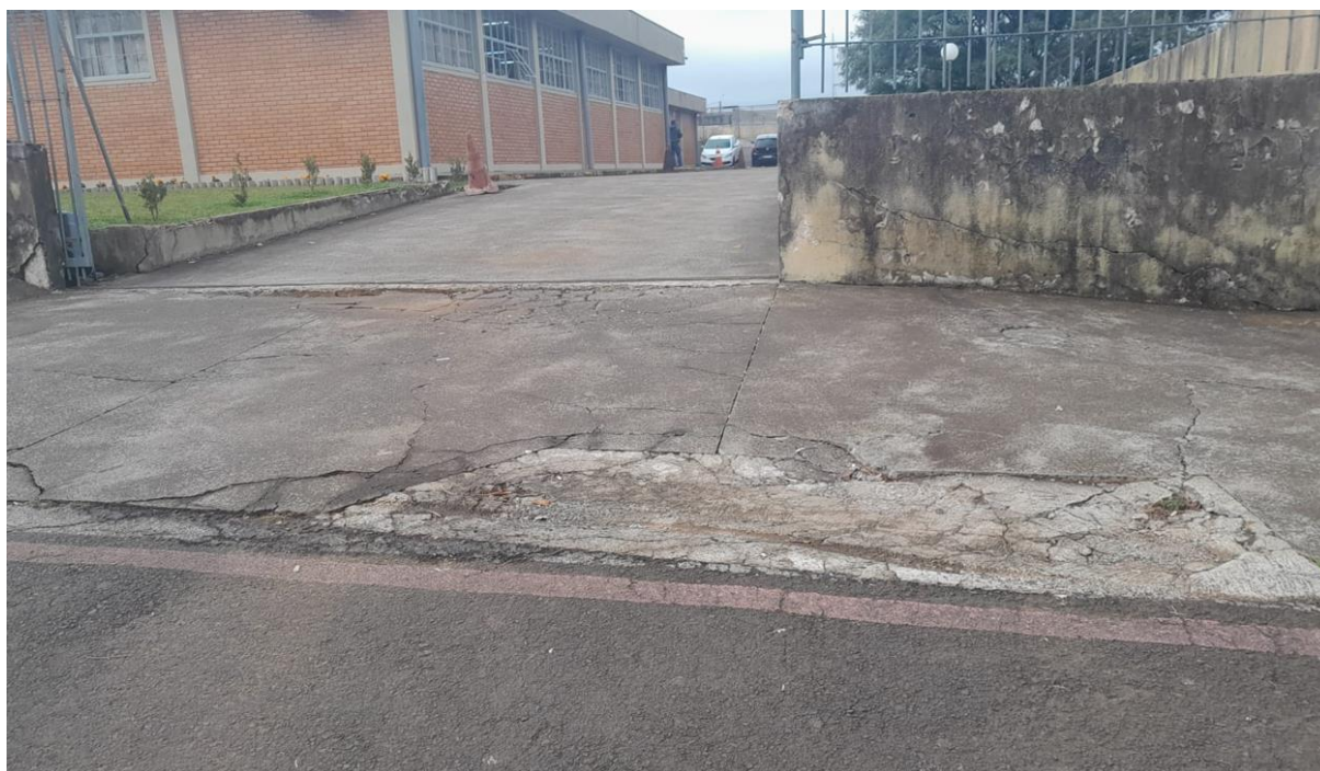
Imagem 7: Calçada a ser reconstruída
