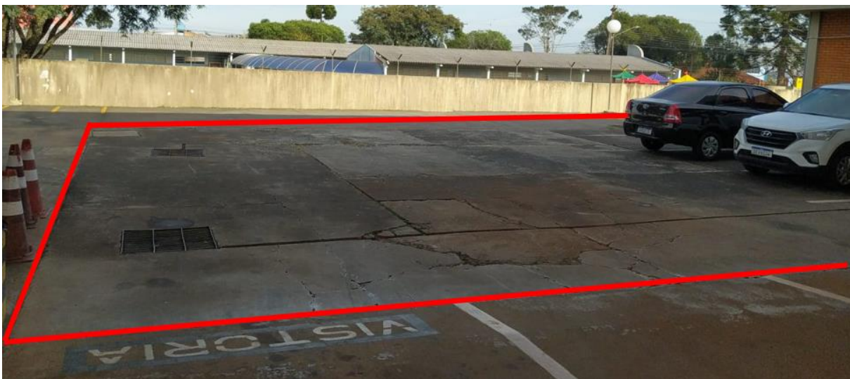
Imagem 2: Pavimento a ser substituído (entrada da cobertura de vistoria)
