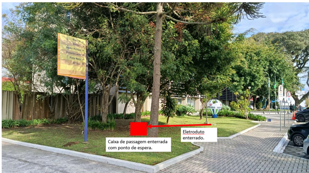
Imagem 18: Local de instalação de ponto elétrico.
