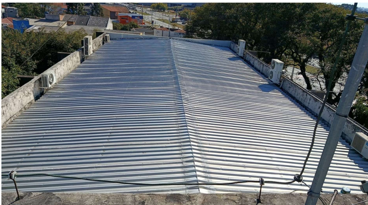
Imagem 13: Instalação de rufo sobre platibandas.
